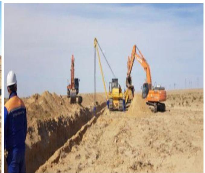
Проведен капитальный ремонт на участке МГ «Окарем-Бейнеу» с заменой 100 дефектных трубных секций.
