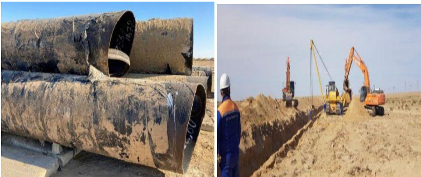
Проведен капитальный ремонт на участке МГ «Окарем-Бейнеу» с заменой 100 дефектных трубных секций.
